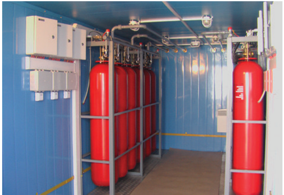
Стойки с электронными весовыми устройствами
