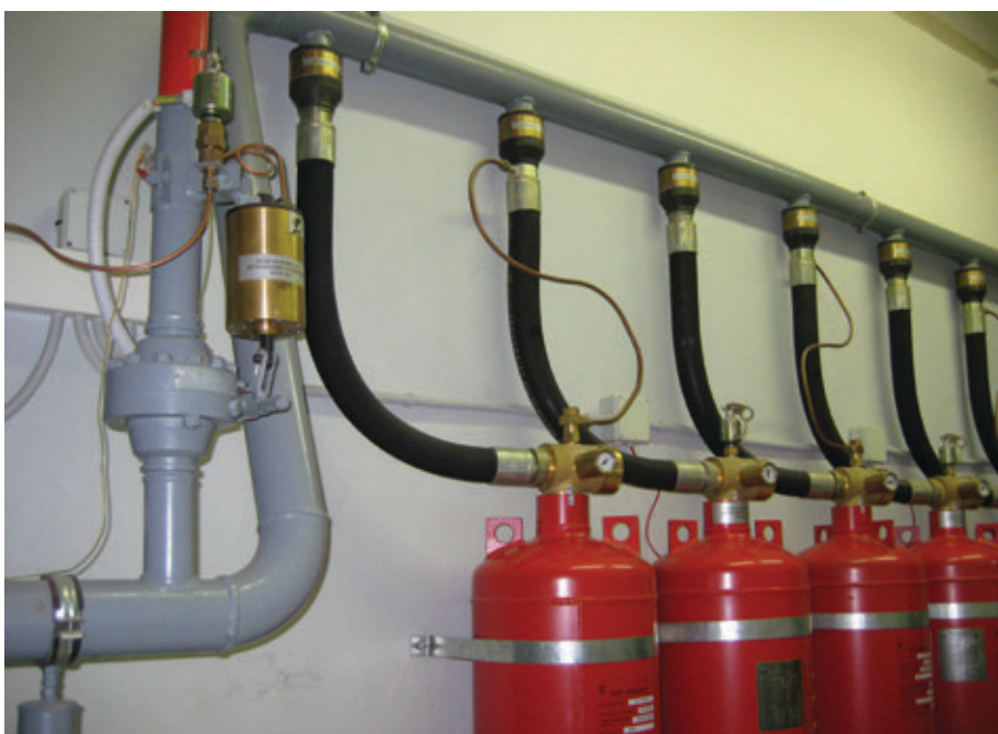
Модульная установка газового пожаротушения на основе МГП-50-100
